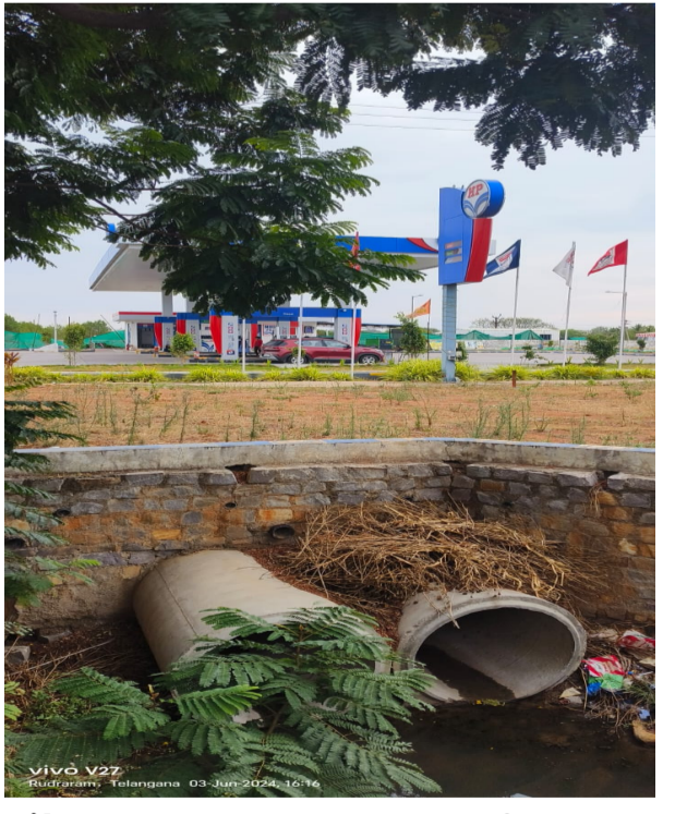
పెట్రోల్ బంకుకు ఎదురుగా కట్టడం గురించి గొలుసుకట్టు కాలవ పై ఉన్నట్టువంటి కల్వర్టు
